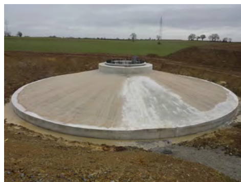
PHOTOGRAPHIE D'UNE FONDATION D'ÉOLIENNE
